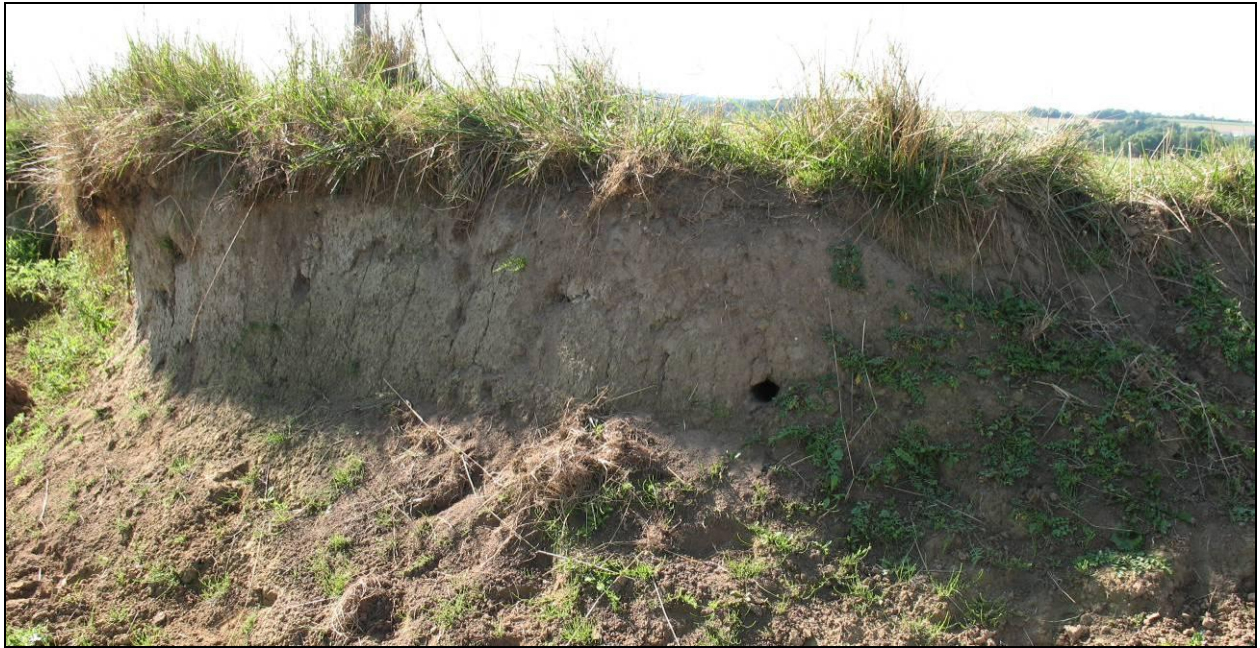
Figure 24 : Berge remarquable en retrait entretenue par le passage répété des bovins aux Paroches
