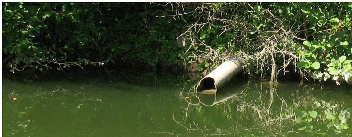
Figure 21 : Rejet à Vignot
