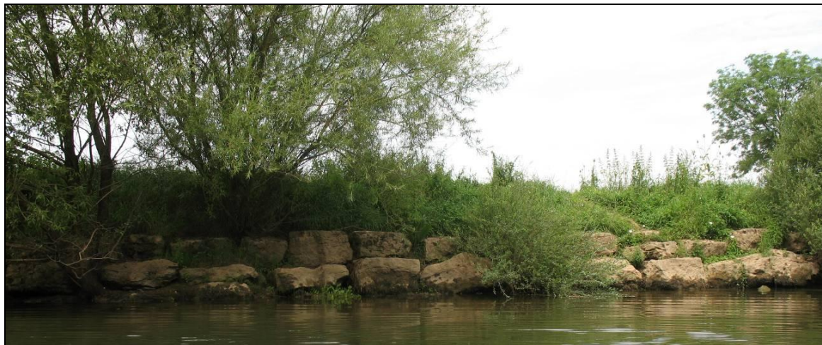
Figure 20 : Enrochement à Brixey-aux-Chanoines
